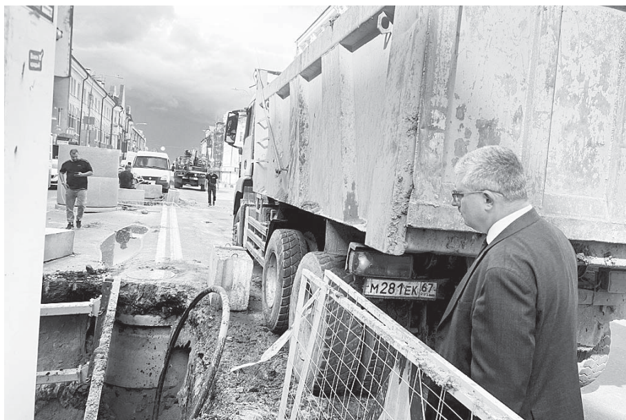
Последний капитальный ремонт на улице Большой Советской проходил в 2001 году
