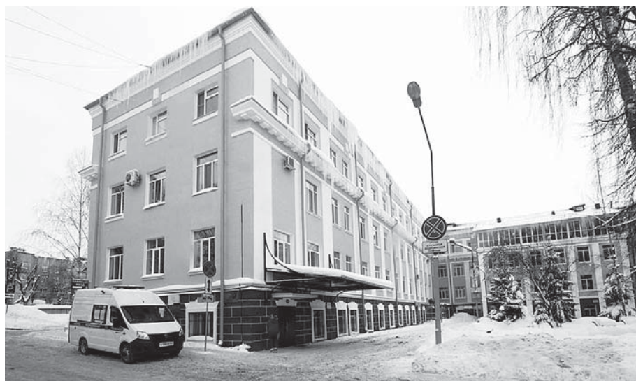
Как изменился архитектурный ансамбль отремонтированных корпусов СОКБ, может оценить каждый смолянин, прогулявшись по ее территории
