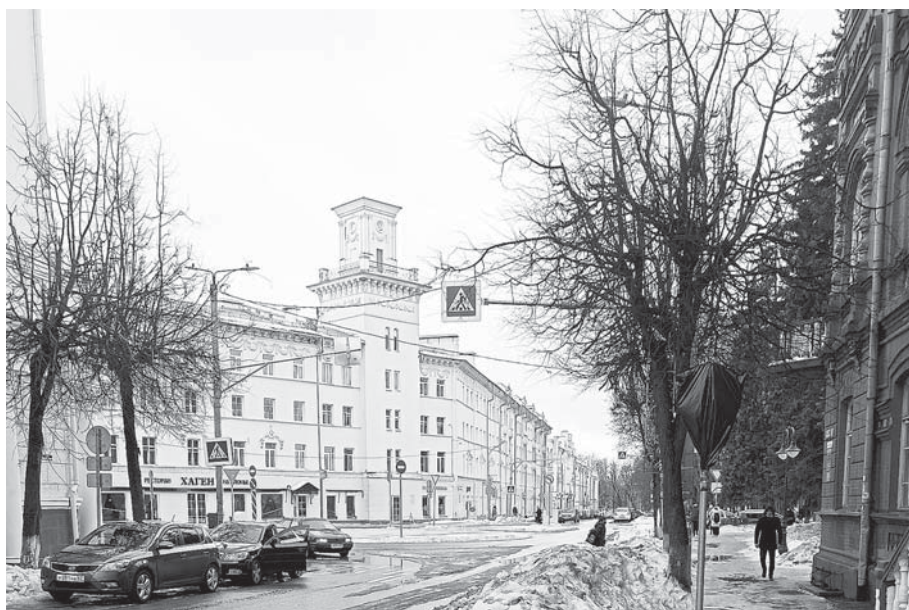
"Дом с каланчой" на улице Коммунистической. Вышка предназначалась для пожарного наблюдения
